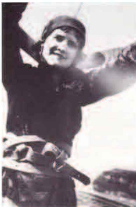
Tante Francine au sommet du pylône de 113 m. de Radio-Normandie Aunt Francine at the top of the 113 m pylon of the station
